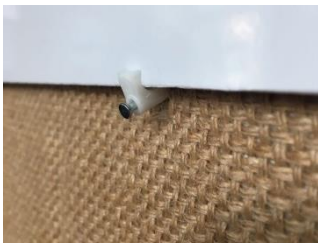
Instalação do prego com gancho numa placa de madeira coberta por serapilheira.
